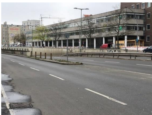
Einfahrt Tunnel an der Badenschen Straße (Richtung Norden)
