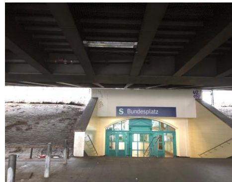
Ein weiterer, nicht barrierefreier und schlecht beleuchteter Zugang zu S-Bahn ist unterhalb der Autobahnbrücke und nördlich oder west- lich nur über den P&R-Platz erreichbar. Von der Bundesallee oder von der Bernhardstraße.
