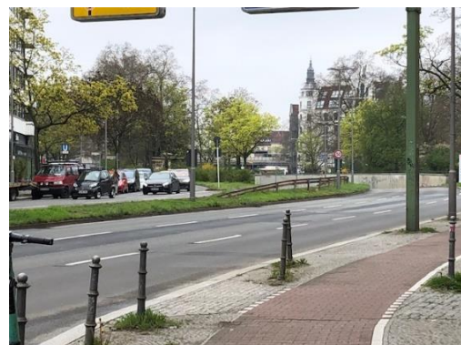
Einfahrt in den weiteren Tunnel am Bundesplatz (Richtung Süden)
