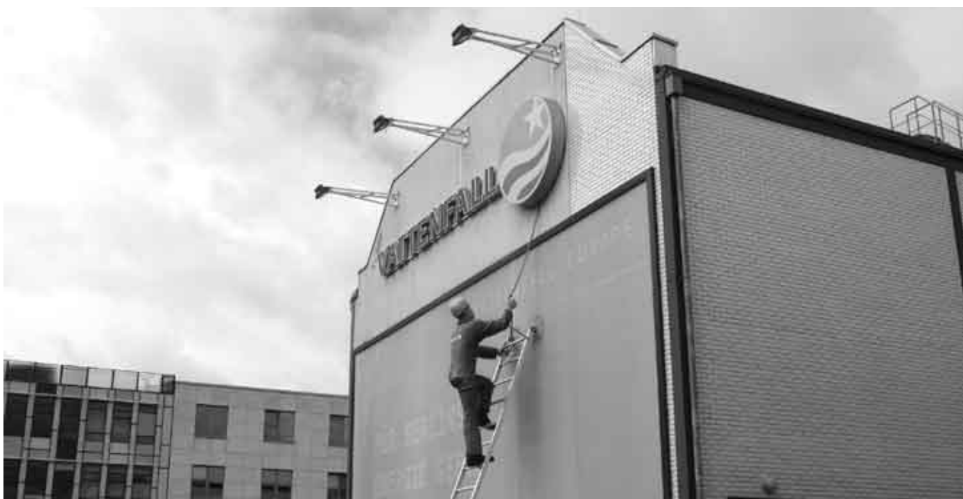
Die Vattenfall-Kältezentrale am Potsdamer Platz. Steht hier demnächst ein kommunaler Mitarbeiter auf der Leiter?
